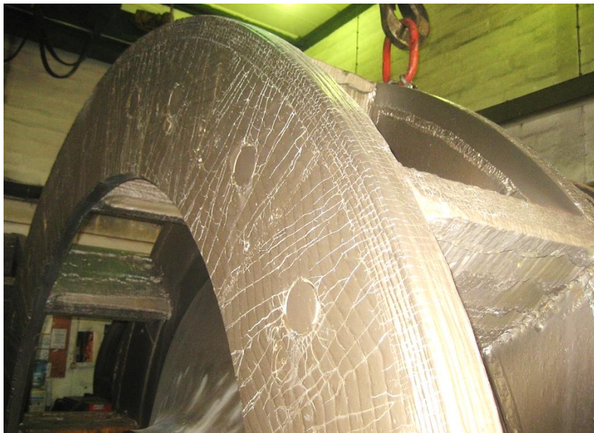
Sanacija rotorskog kola ventilatorskog mlina za ugljen
