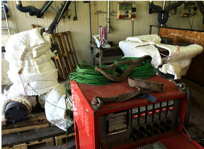
Sanacija pukotina na razdjelniku parne turbine – zavarivanje i toplinska obrada
