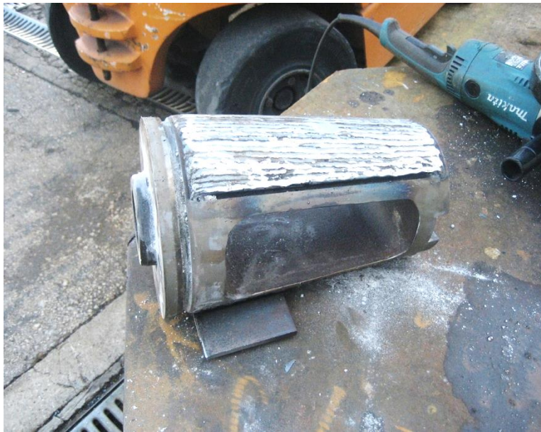
Navarivanje sjedišta ventila pregrijača pare
